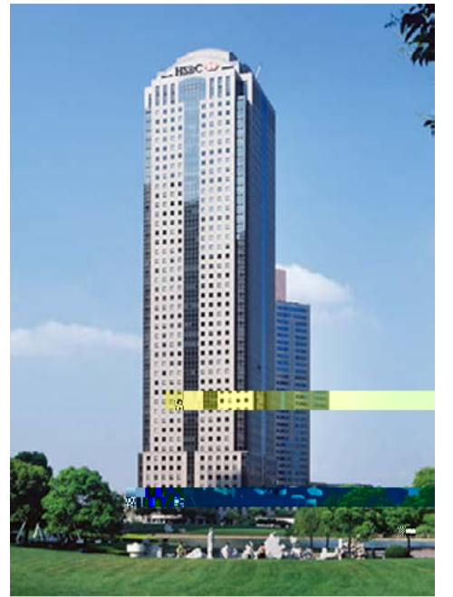
上海森茂国际大厦空调工程
