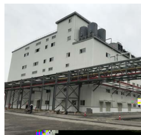
中粮东莞产业园 1000T 精炼车间
