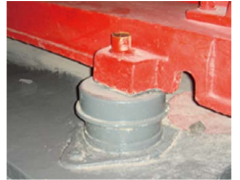
图8 使用弹簧隔震器安装
