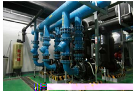
图4 使用减震垫安装
