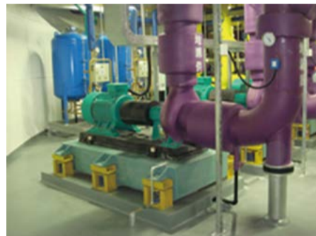
图5 使用弹簧式避震器安装示意图
