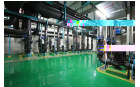
图9 使用橡胶隔震器安装
