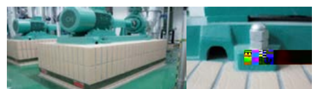
图3 使用减震垫与基座组合减震安装
