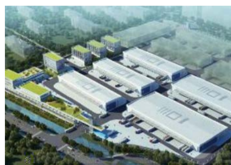
无锡现代综合物流港一期工程
