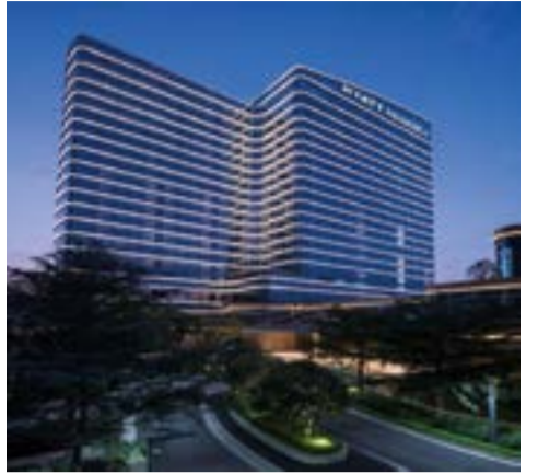
福州凯悦酒店机电安装工程
