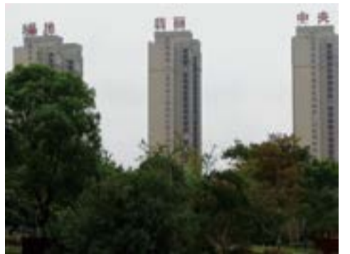
扬州晶丽项目消防工程
